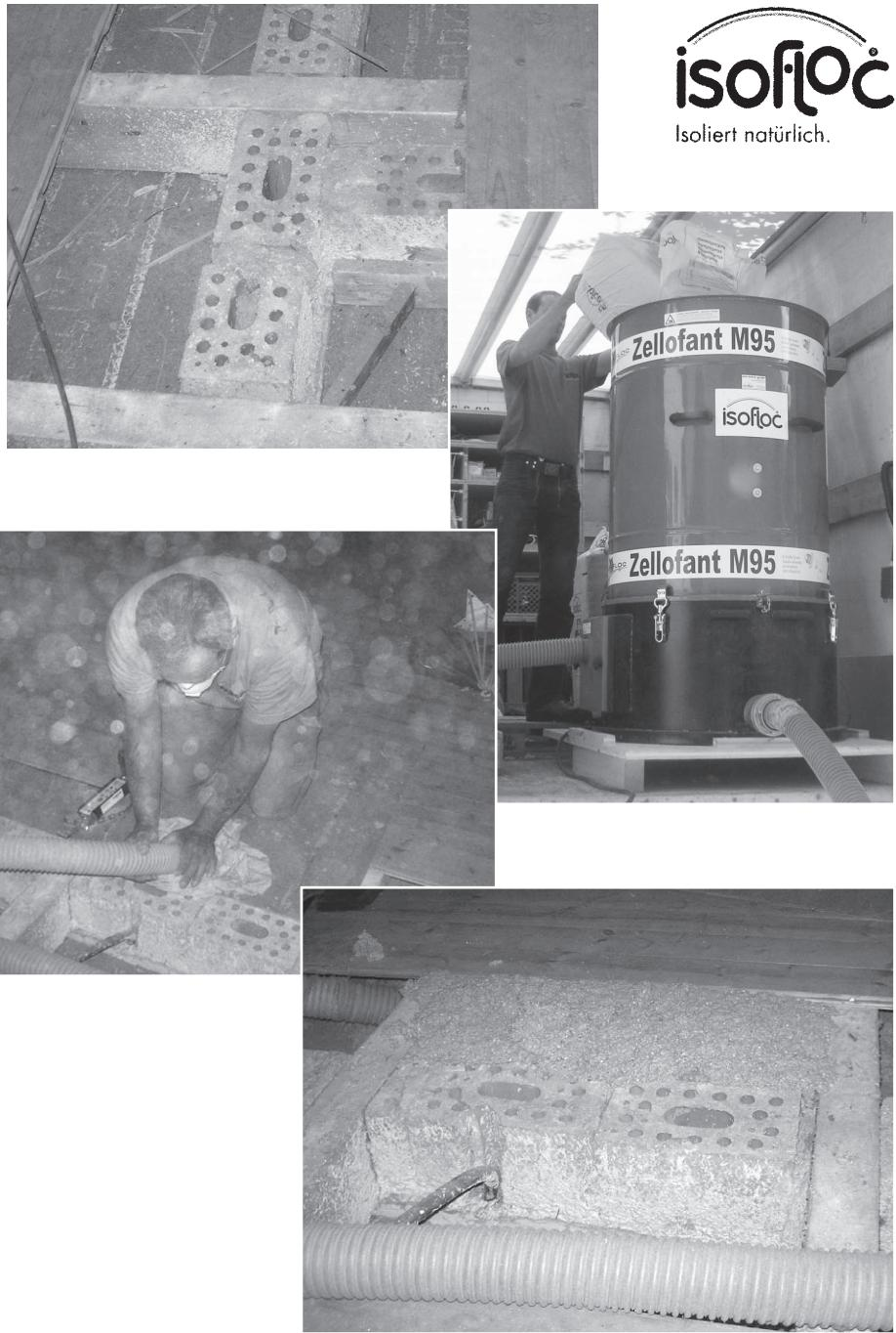
kel hinein – das macht isofloc zur 100 % Dämmung. Es ist setzungssicher und hält Mäuse und Ungeziefer fern. Unschädliche Zusatzstoffe und aus Mineralien gewonnene Borate verhindern Schimmelpilz und Fäulnis und gewährleisten den Brandschutz.
